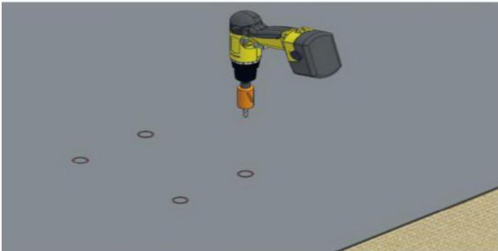
4 Убедитесь в том, что длина вашего штифта позволяет ему пройти сквозь основание кровли, войти в бетонную основу, и при этом штифт выступает из отверстия в достаточной мере для того, чтобы насадить на него шайбу и закрутить гайку.
