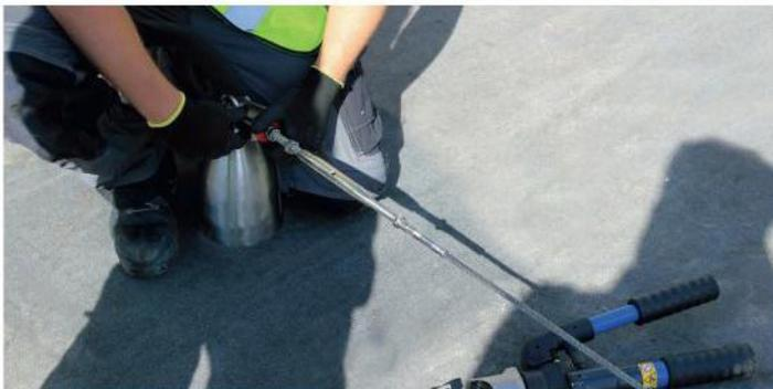
4. Теперь можно затянуть гайки на натяжном устройстве, заперев этим винтовую стяжку.
