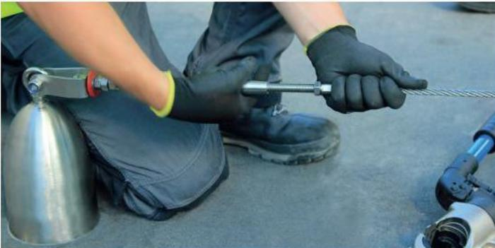
3. По достижении требуемого уровня натяжения, красный индикаторный диск ослабнет и повернется. Хотя это и означает, что достигнут требуемый уровень натяжения (0,8 кН), установщик отвечает за проверку наличия достаточного натяжения на каждом прямом участке, и за равномерное распределение натяжения по всей системе.
