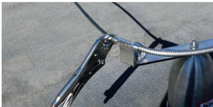
4. По достижении начала линии, вы вручную создадите оптимальное натяжение троса, достаточное для того, чтобы он не касался поверхности крыши. Это минимизирует нагрузку на натяжное устройство линии.
