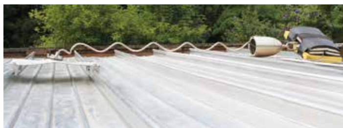
Испытания на алюминиевой кровле со стоячим фальцем
