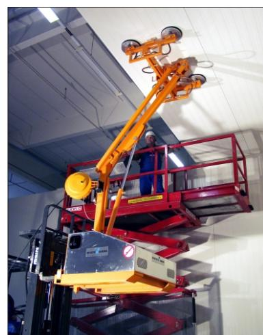
Рука-манипулятор с гидравлическим приводом обеспечивает легкий монтаж и избавляет монтажную бригаду от тяжелой физической работы. С помощью данного оборудования можно с легкостью монтировать стеновые панели и потолочные перекрытия.
