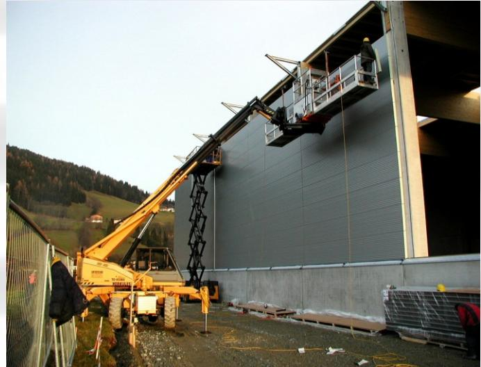
Вакуумные устройства для монтажа сэндвич-панелей, грузоподъемностью до 400 кг.
